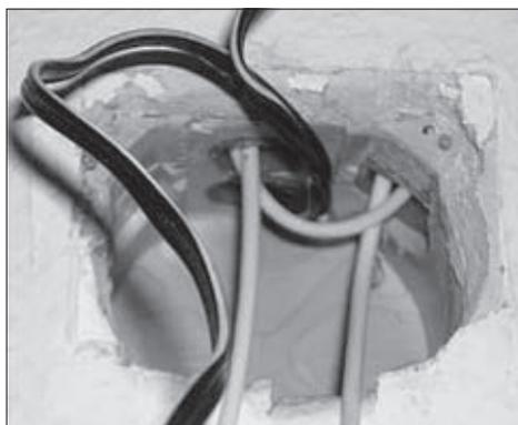
Figure 53 : boîte d'entrée servant à la dérivation. Pour réduire au mieux les pertes de performances sur les derniers mètres, les fibres optiques à courbure optimisée de la dernière génération constituent la meilleure protection des investissements.
