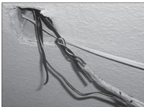
**Figure 54 :** dans la salle de séjour : l'ancien câble cuivre, par ex. U72, et les fils d'installation I83 peuvent être utilisés comme aide au tirage pour les nouveaux câbles optiques. Mais attention, toujours tirer au moins un autre câble de communication avec le câble optique. De plus, lors du tirage de câbles optiques dans des tubes existants, il faut se souvenir qu'ils sont parfois très vieux et peuvent poser des problèmes pour le tirage.
