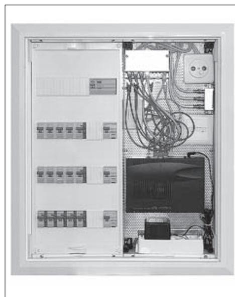
**Figure 29 :** distributeur multimédia, électricité et communication juxtaposés
