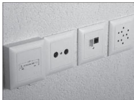
**Figure 55 :** dans l'appartement, derrière la bibliothèque ou le téléviseur, à proximité d'une cloison. Le Fibre to the Home dans les conditions du réel. Le positionnement de la prise FTTH résulte de la place disponible dans les appartements. Vérifier que l'emplacement choisi ne soit pas source de gêne.
